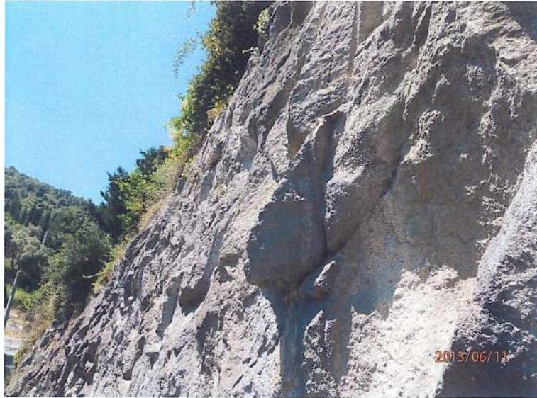
**Photo n° 22 : écaïlle instable avant le pont de la D2210 à la sortie du village côté ouest**
