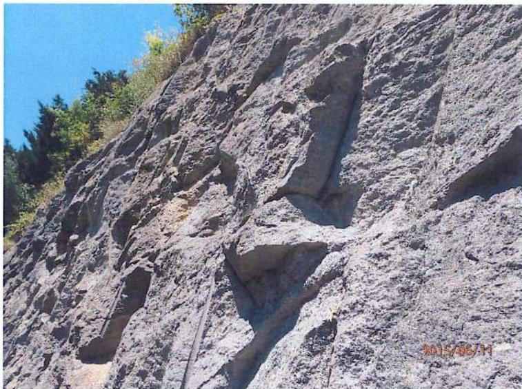
**Photo n°23 : écaïlle instable avant le pont de la D2210 à la sortie du village côté ouest**
